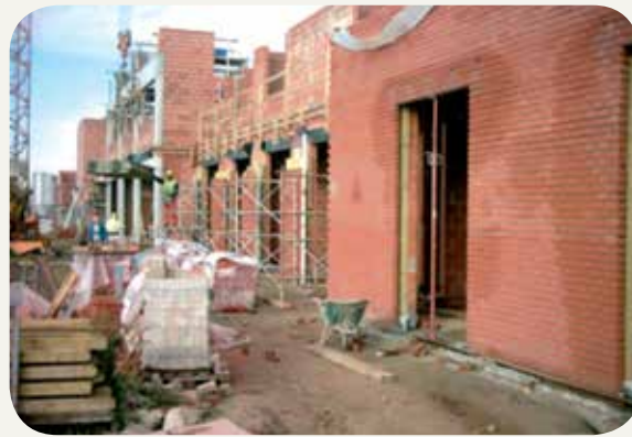
De nieuwbouw te Gavere (2005)
