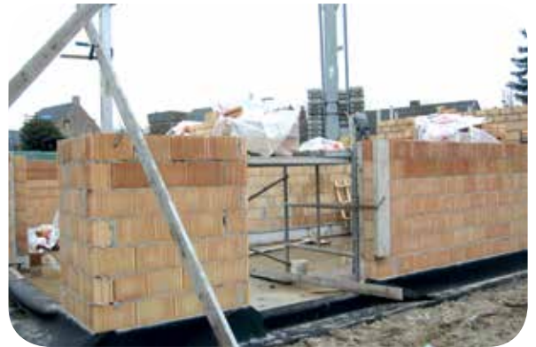
Bouw nieuw halfweghuis (2014)
